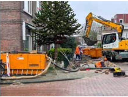
KLIMOPSTRAAT HOEK MAGNOLIASTRAAT
